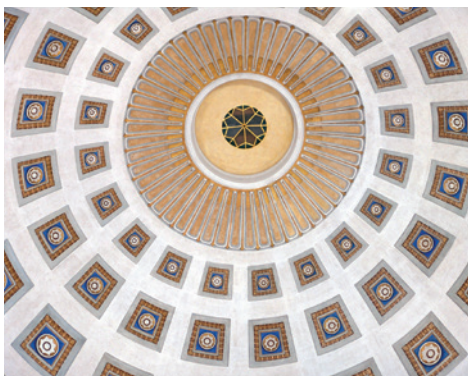
Innenansicht der Kuppel.
